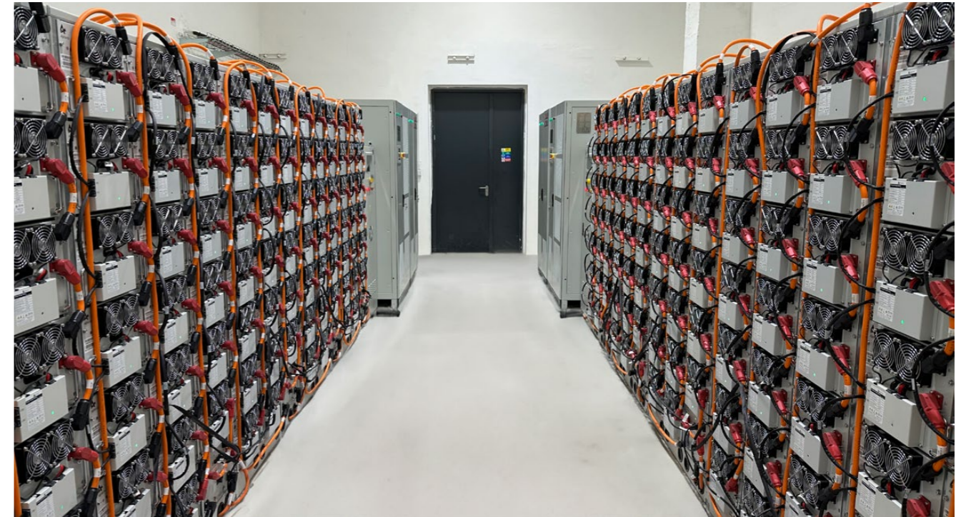
Přebytečnou energii kampus ukládá ve vlastním bateriovém úložišti. Zdroj: Archiv Urbanity
