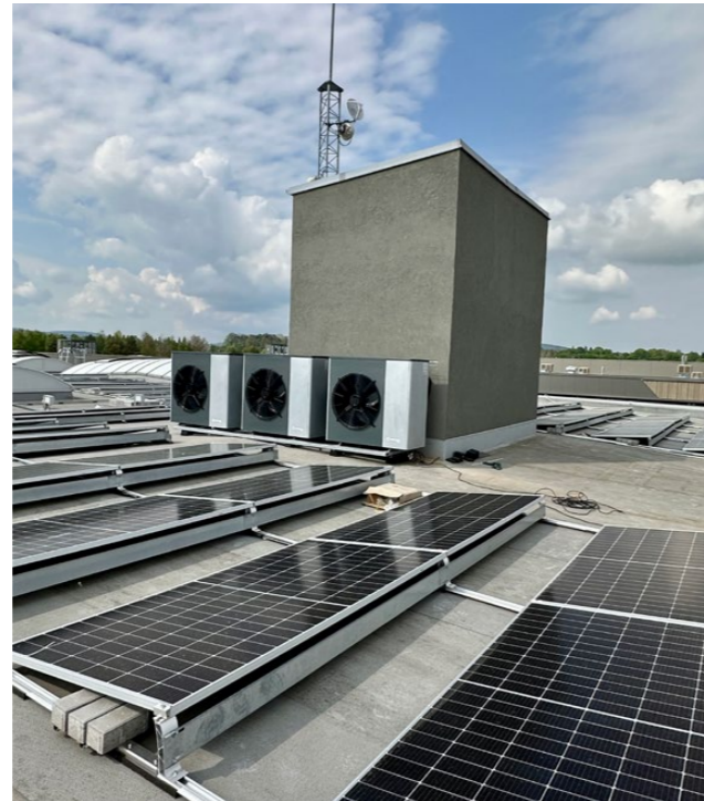
Střechy hal pokrývají solární panely a tepelná čerpadla. Zdroj: Archiv Urbanity
