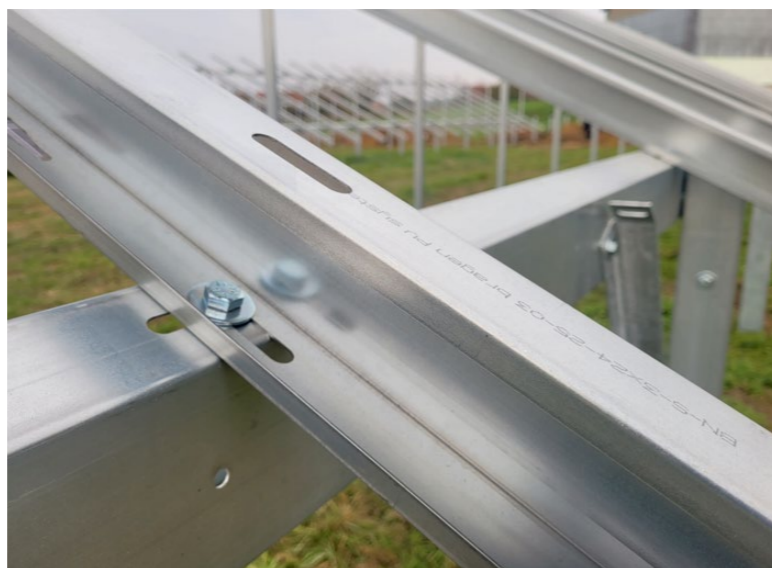
Ocelové profily pokrývá speciální antikorozi vlnstva. Zdroj: Bragen
