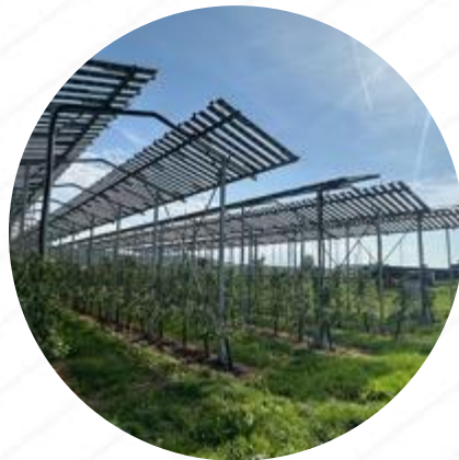
Vysoké vertikální instalace (ovoce) Orientace: východ-západ
