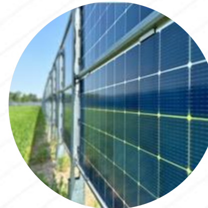
Vertikální instalace (obiliny, brambory atd) Orientace: východ-západ
